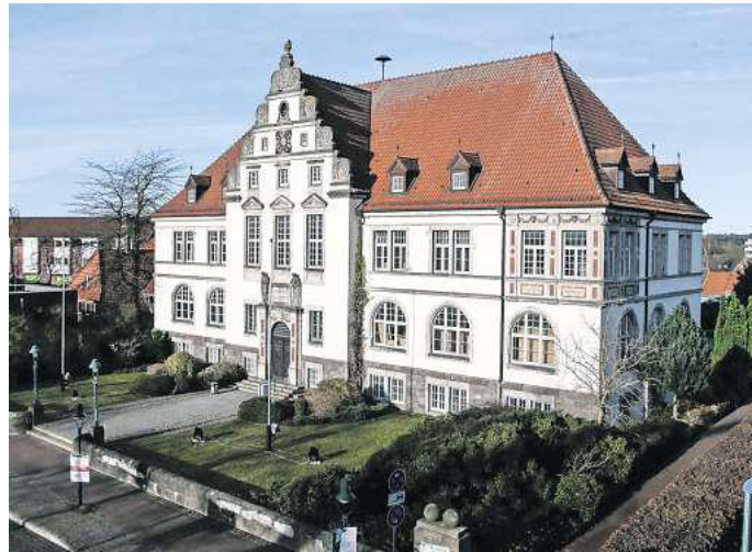
Das Amtsgericht in Bad Schwartau.
