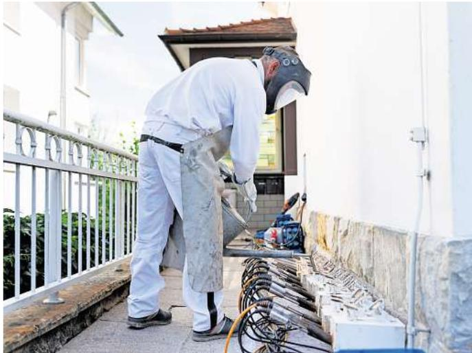
Eine defekte Horizontalsperre wird mit einem Spezialparaffinverfahren repariert. Foto: C. Gollhardt
